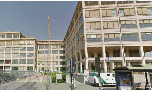
Ingresso laterale e notturno (da mezzanotte e notturno) Side entrance & Night entrance (from midnight to 6 am)
